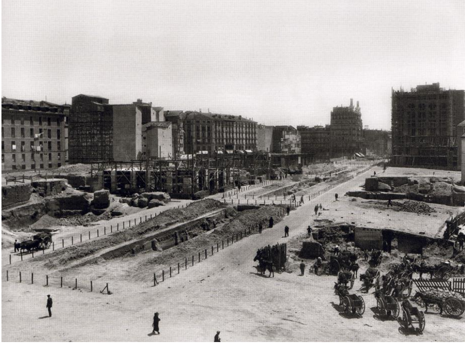
Construcción de la Gran Vía, 1921.
