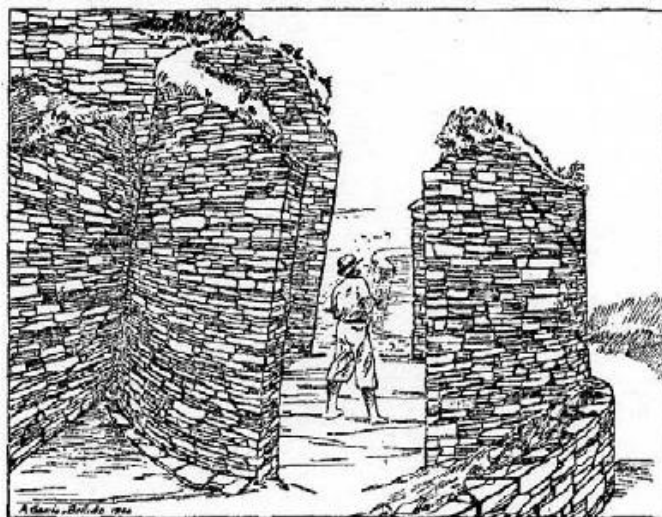
Figura 26. Estructura nº 1, cuya ruina alcanza aún los 4 metros (García y Bellido, 1940: 291).
