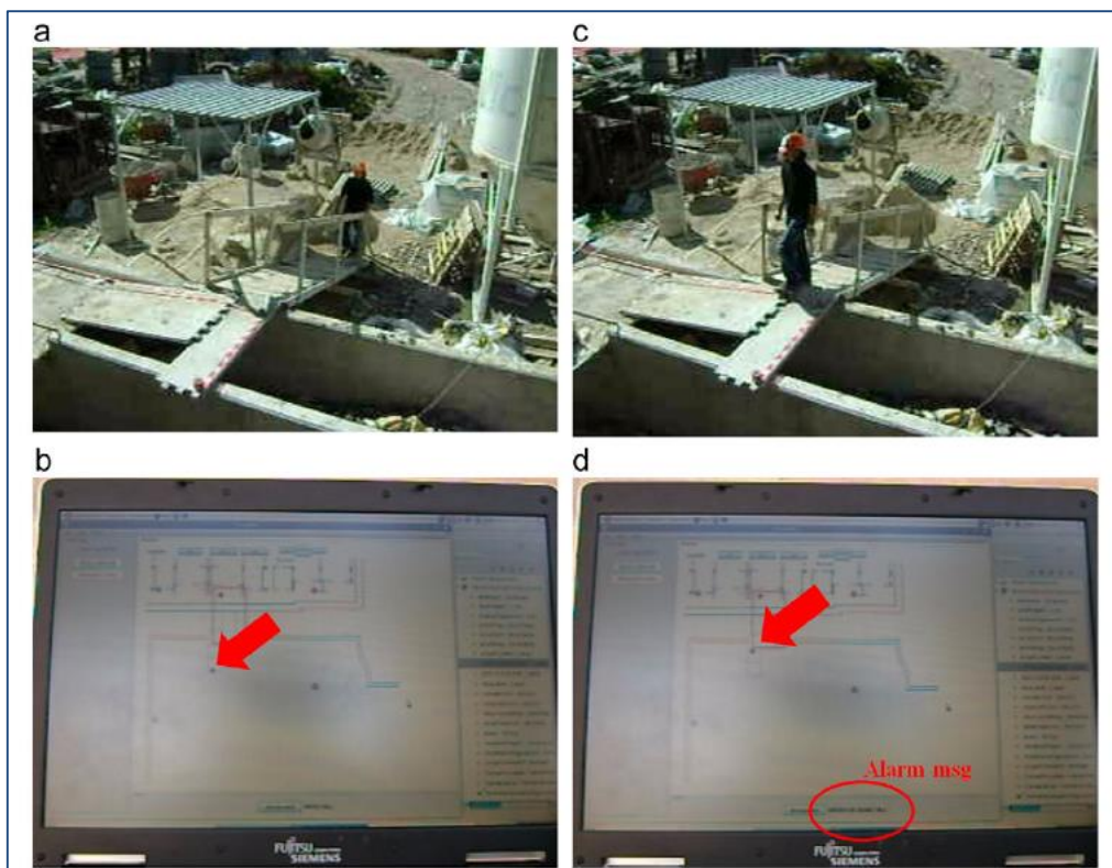
Figura 7.7. Momento en el que el trabajador se acerca a la zona de peligro (a) con el correspondiente monitoreo (b). Momento en el que el trabajador se encuentra en la zona de peligro (c) y alerta en el sistema (d).
