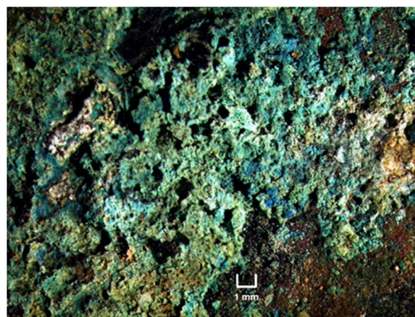
Figura 27. Fotomicrografía de los productos de corrosión del cobre: cloruros de cobre en tonos verdes y carbonatos de cobre en azul. ©M. Tuégano. 2016
