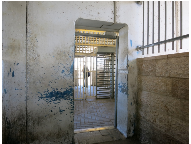
Figura 2: Torniquete de entrada al checkpoint/M. Martínez Losa
